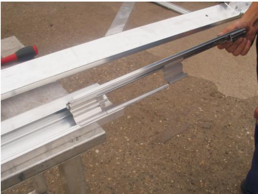
Einschieben des Press- und Federprofils in das Modulprofil. Dazu 150 mm Distanzprofil zwischen den Federn und 60 mm zwischen dem nächsten Pressprofil einfügen.
