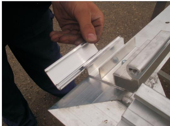
Einschieben des Klemmprofils in das Grundprofil und Sichern mit Schrauben
