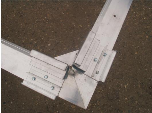
Befestigung des Grundprofils im Abstand von genau 92 mm von der Kante der Tragkonstruktion
