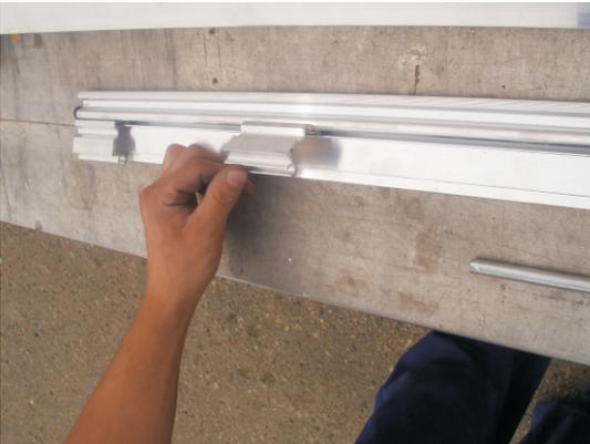
Einschieben des Federprofils in das Pressprofil
