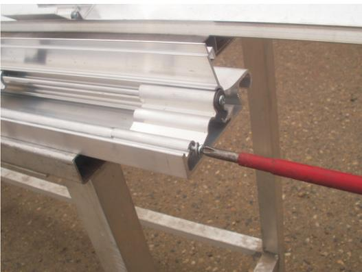
Sichern des Modulprofils mit Schrauben.
