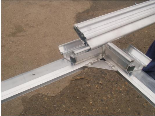
Einschieben des Spannmoduls in das Grundprofil.
